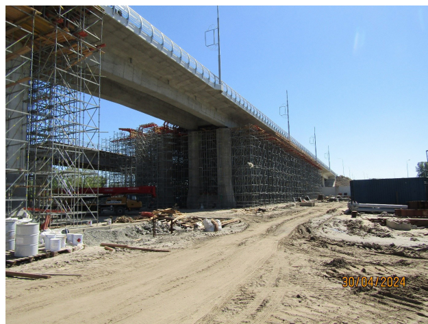
Іл. 2. Загальний вигляд конструкції досліджуваної прогонової будови на стадії будівництва. 2024. [Світлина Р. Полюги]
