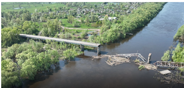
Іл. 1. Загальний вигляд споруди до відновлення: пошкодження та дефекти. 2022. [Світлина С. Стояновича]
