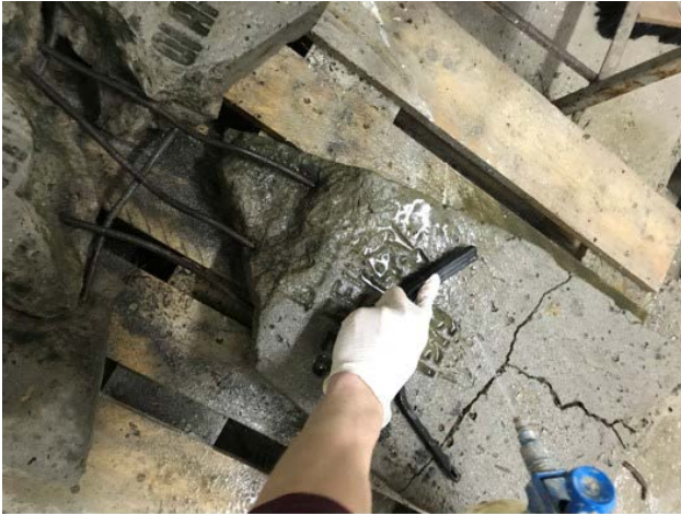
Іл. 7. Очищення поверхні водою та слабким мильним розчином від залишків бруду. 2018. [Світлина автора]
