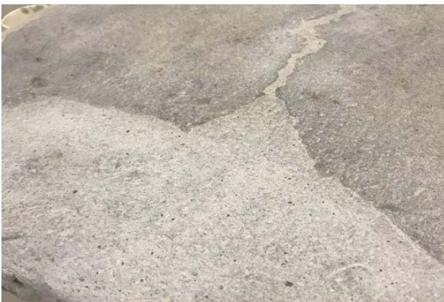
Іл. 9. Фрагмент надання доповненим частинам фактури, максимально схожої до натуральної. 2018. [Світлина автора]
