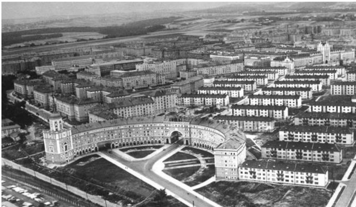
Іл. 4. Аерофотознімок з будівництва Поруби. Найстаріша частина – перші райони. [10]
