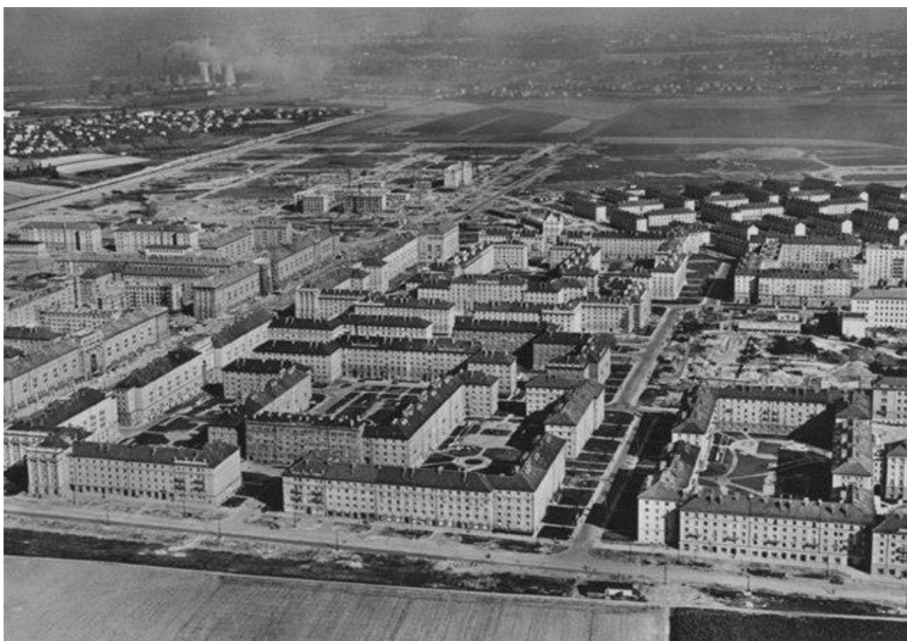
Іл. 5. Будівництво Поруби в середині 50-х років. Вид з боку вул. 17 Листопада, ліворуч – Головна вулиця, що будується, на задньому плані – електростанція в Тржебовіці. [10]
