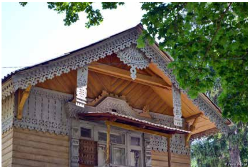
Іл. 3. Дача М. Максимовича (м. Боярка, вул. Хрещатик, 20). Фрагмент фасаду з вул. Хрещатик. [15]
