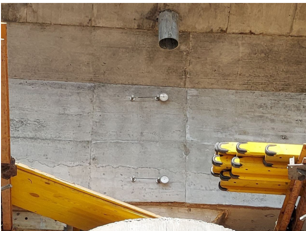
Іл. 4. Загальний вигляд розміщення механічного мікроіндикатора на балці прогонової будови. 2024. [Світлина С. Стояновича]
