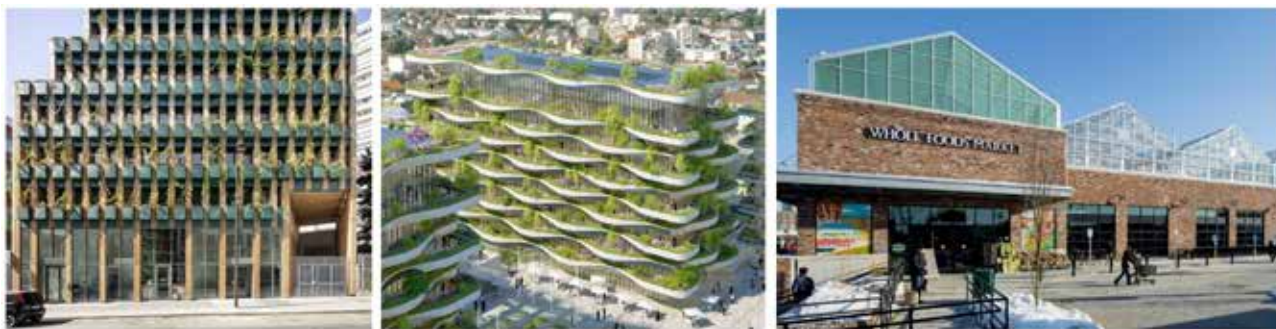
Іл. 5. Приклади облаштування фасадів: зліва – Edison Lite Apartment Building [14]; по центру – The Foam of Waves [15]; справа – маркет «Whole foods market» [16]
