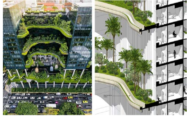
Іл. 8. Parkroyal Collection Pickering. Сінгапур. (WOHA Architects Pte Ltd). 2013. [2]
