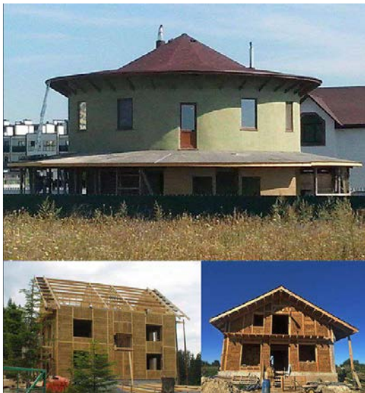
Лл. 5. Каркасні будинки [11]
