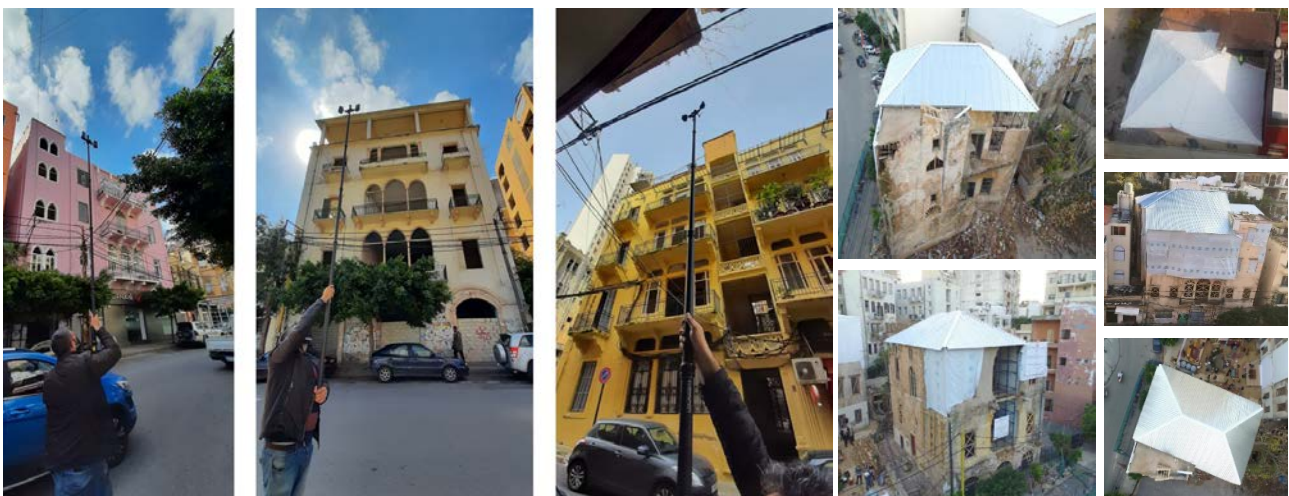
Іл. 3. Покрокове накопичення кадрів. Тимчасові брезентові накриття для ізоляції від опадів вцілілих конструкцій. [17]
