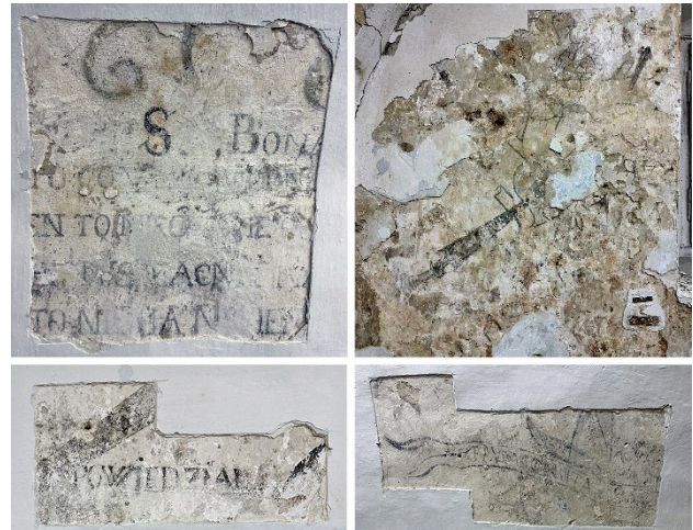
Іл. 17. Зондажі розписів першого історичного шару в приміщеннях третього поверху. XVII ст. [Світлини М. Каплінської]
