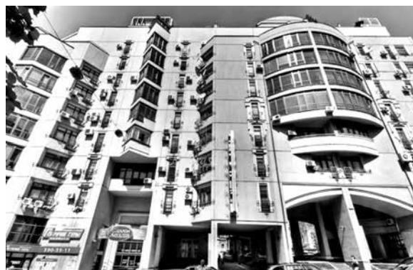
Іл. 5. Житловий будинок у м. Києві на вул. Бульварно-Кудрявській, 36 (архіт. Г. Хорхот, В. Журавель, І. Білявська, інж.-констр. Ю. Масін. [Світлина з архіву автора]
