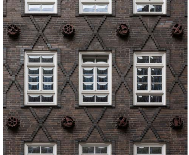
Лл. 5. Розшивка цеглою фасаду та керамічні вставки Шпрінкенхофу. Арх. Ф. Хьогер. 1927–1943. [16]
