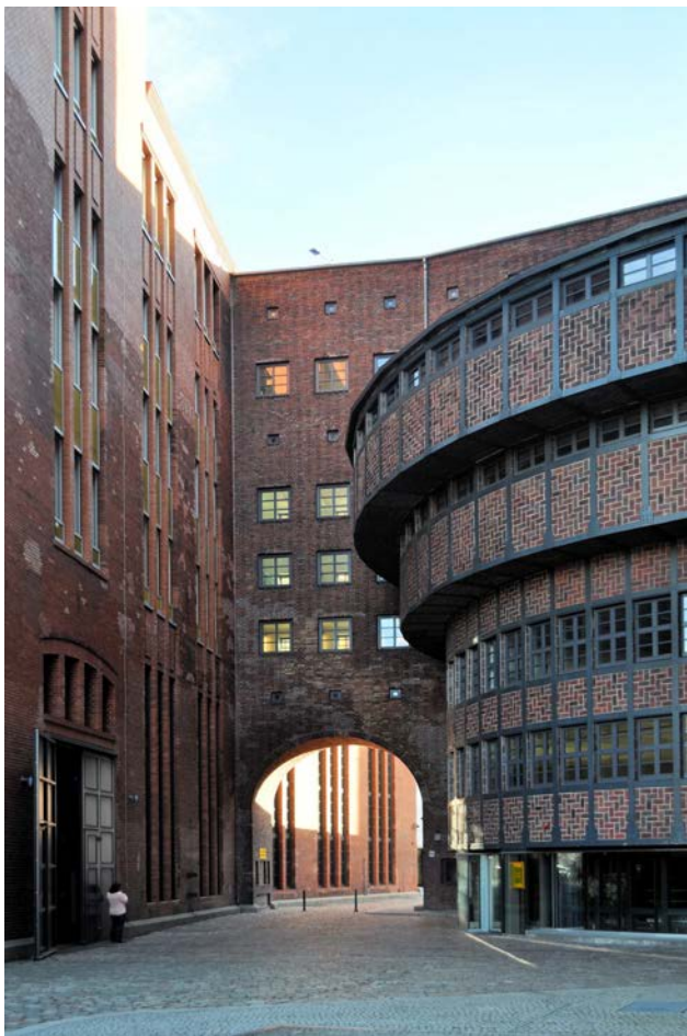
Іл. 6. Підстанція Buchhändlerhof у Берліні. Арх. Г. Мюллер. 1927–1928. [18]
